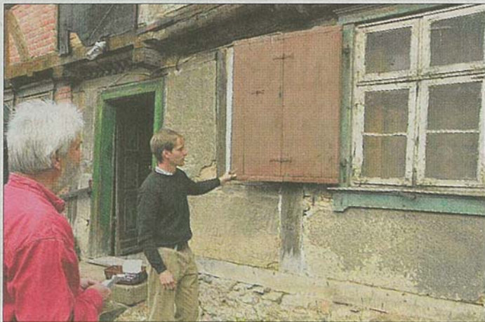
Ein Detail zeigt Christian Lellau am Erweiterungsbau: Hinter Klappläden und Fenster ist eine tapezierte Wand. Foto: Klaus Baier
