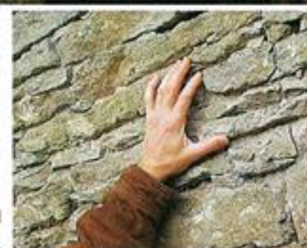
Die Wände hat der Bauherr vom Putz befreit und so das Bruchsteinmauerwerk zu Tage gebracht.
